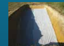
POSE DU GEOTEXTILE
